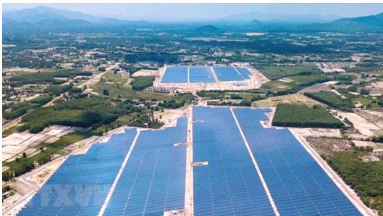
Toàn cảnh dự án Nhà máy điện Mặt Trời Cát Hiệp
