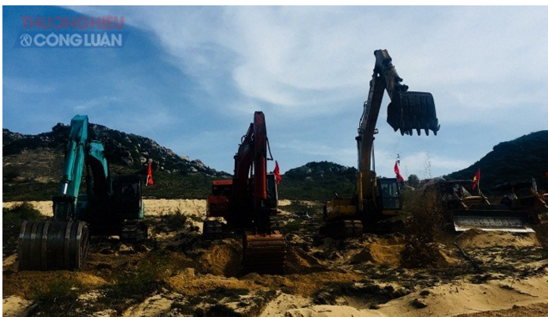
Các đơn vị thi công ra quân động thổ, triển khai dự án. Ảnh: V.H.
