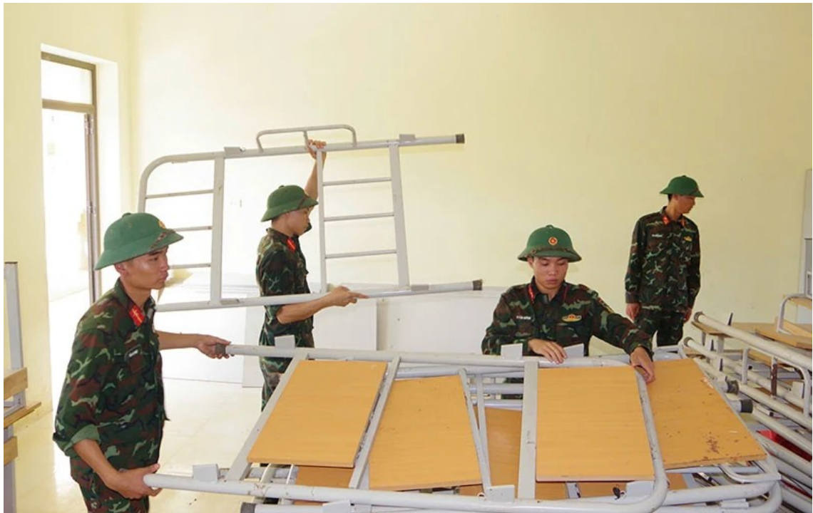
Các lực lượng đã tập trung dọn dẹp, sửa chữa tại Trường Tiểu học Yên Nhân 1, Tiểu học Yên Nhân 2, Trường Mầm non và THCS Yên Nhân
