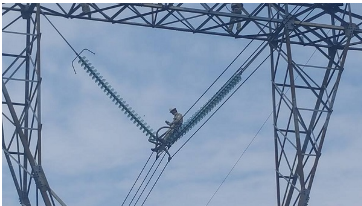
Hệ thống lưới điện quốc gia đang bị quá tải
