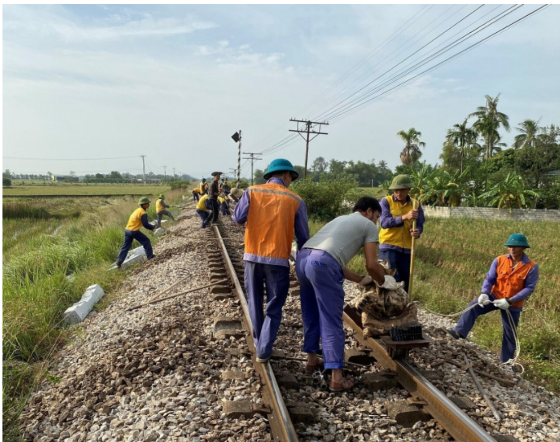
Thi công cải tạo, nâng cấp kiến trúc tầng trên đường sắt Hà Nội - Vinh.
