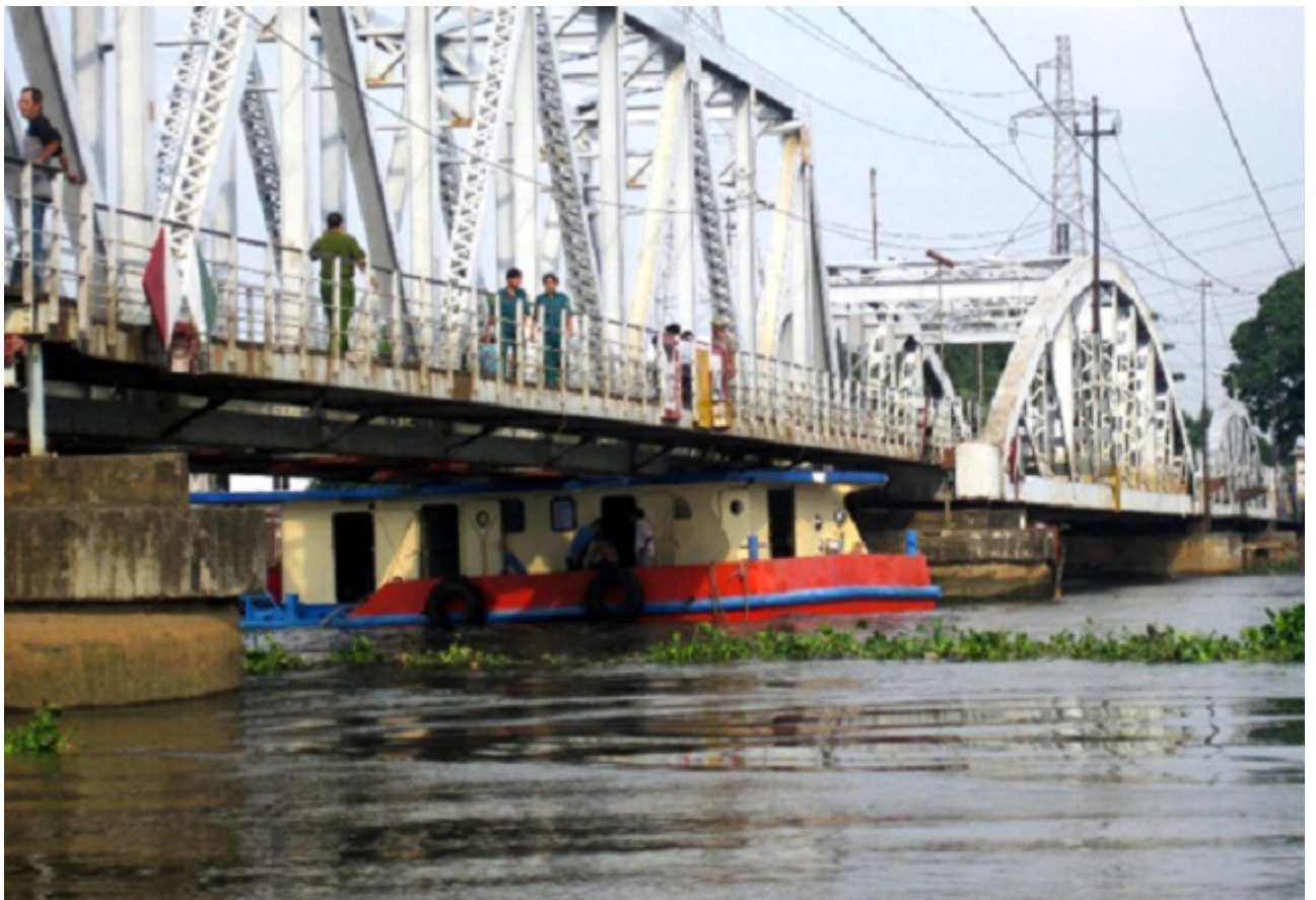
Khu vực cầu sắt Bình Lợi trong tổng dự án BOT Bình Lợi
