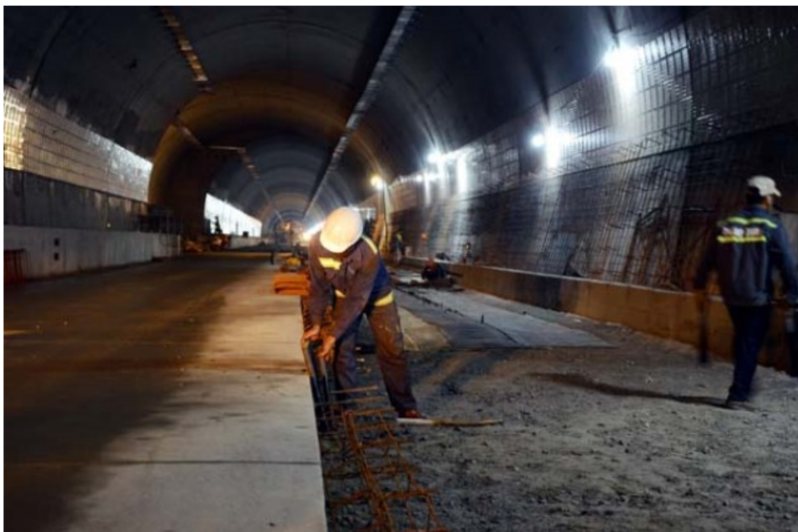
Thi công nốt những mét bê tông nền tại KM 4+00.
