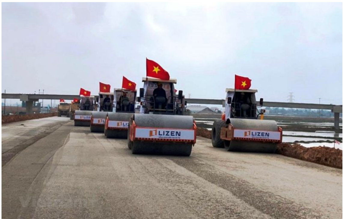
Nhà thầu triển khai thi công đoạn tuyến cao tốc Bắc - Nam phía Đông (Ảnh: Việt Hùng)
