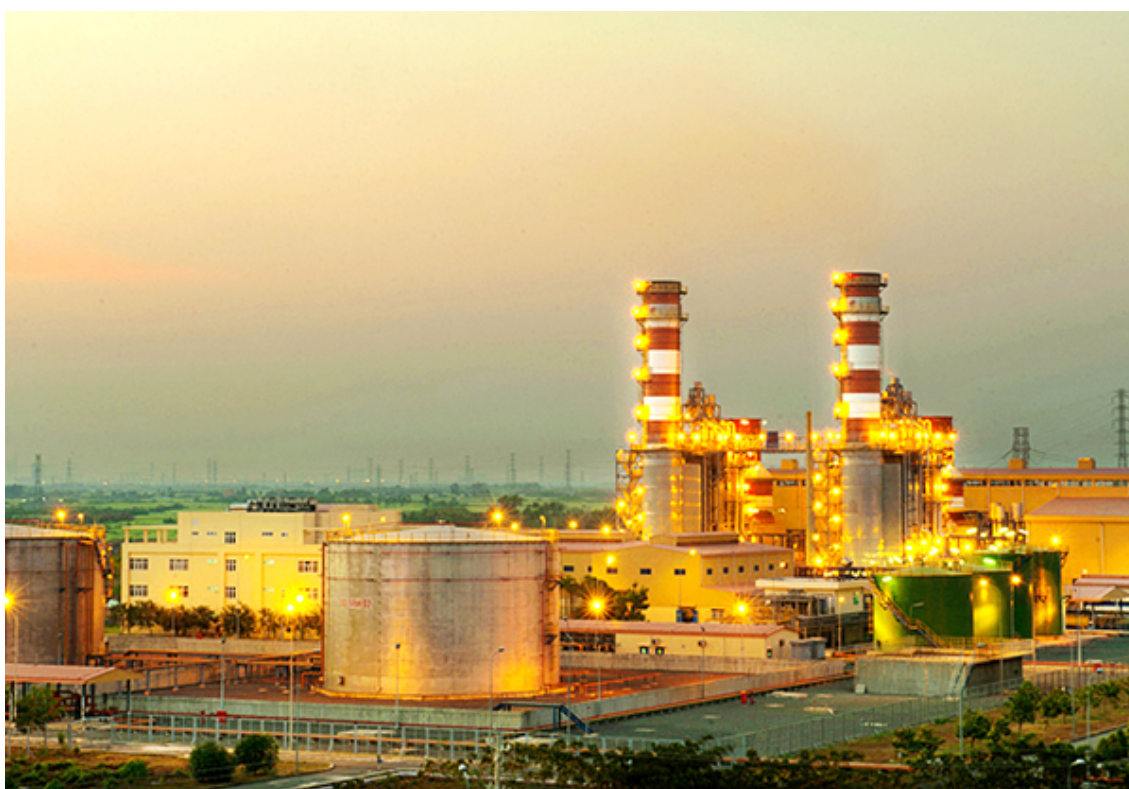
Nhà máy Nhiệt điện Nhơn Trạch 2 của PV POWER tại Đồng Nai. Ảnh: PV POWER.
