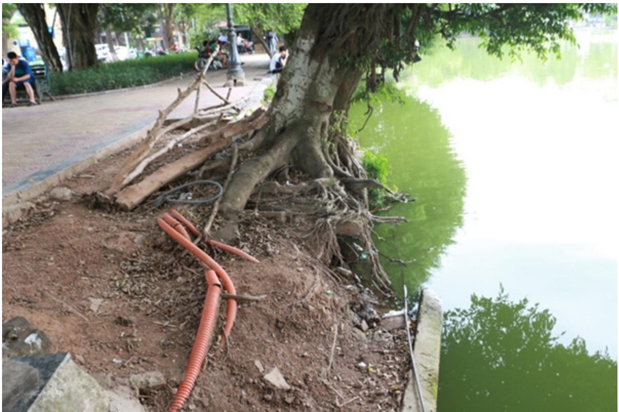
Tình trạng sạt lở khiến cáp ngầm lộ ra, gây mất mỹ quan đô thị
