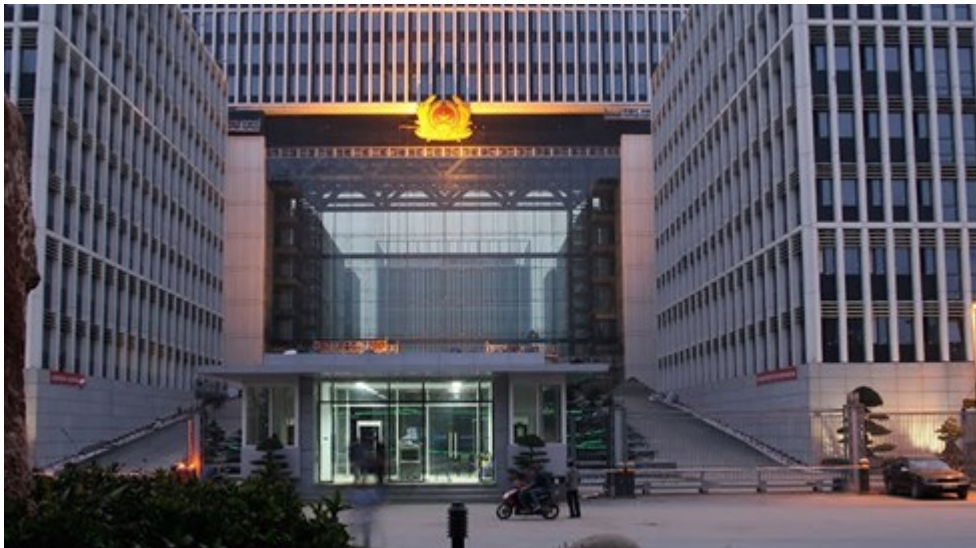
Trụ sở Bộ Công an.
