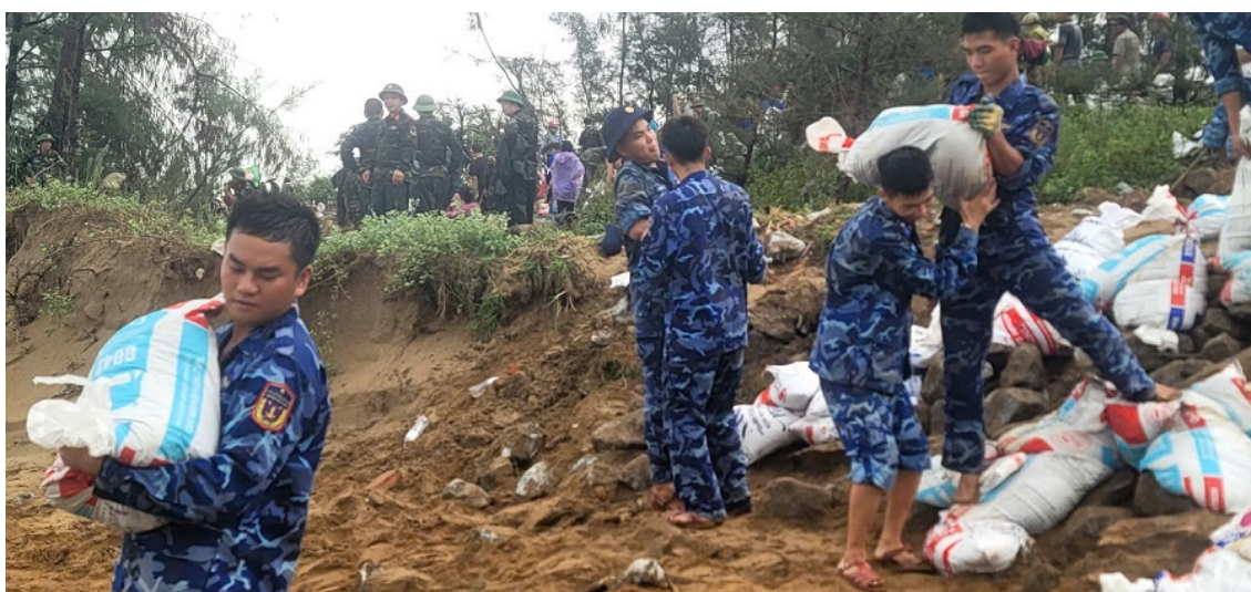
Cán bộ, chiến sĩ Hải đội 102 tích cực cùng Nhân dân gia cố các đoạn đê xung yếu tại xã Đan Hải.
