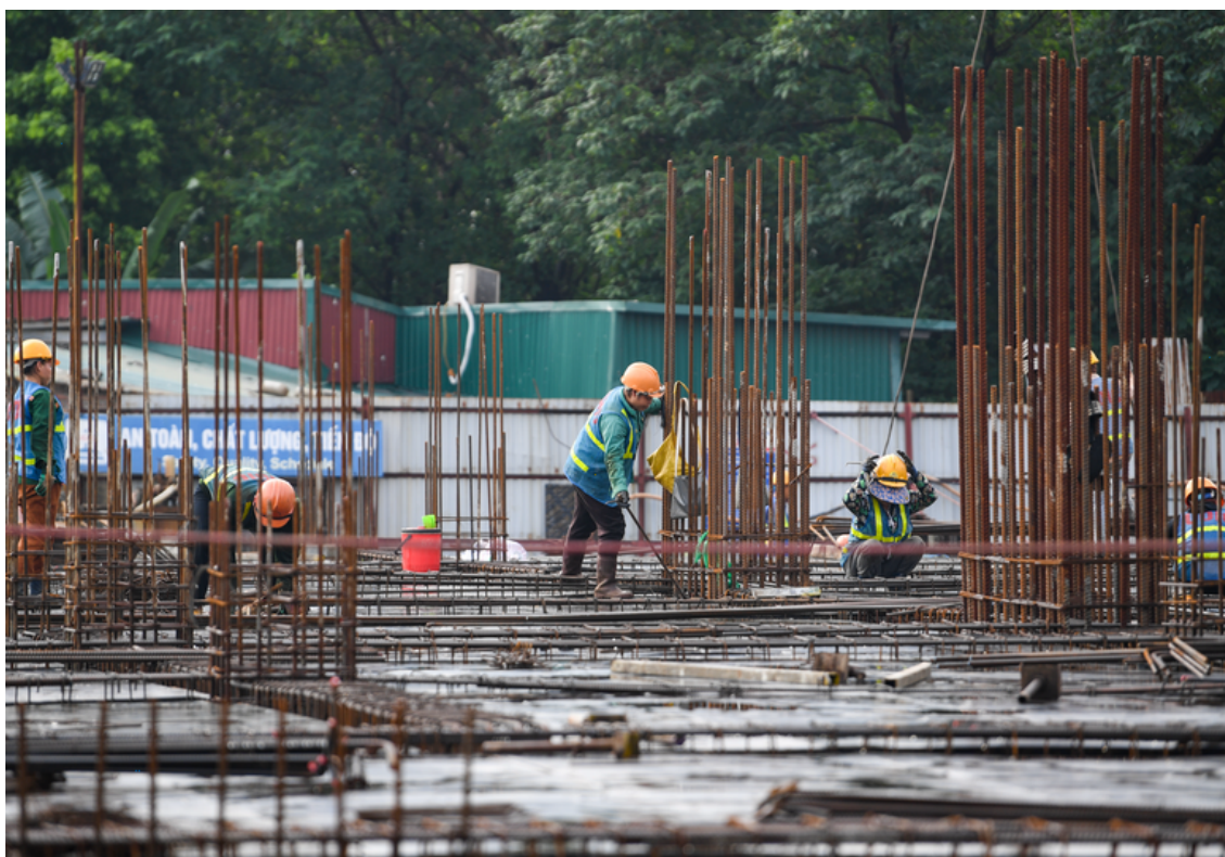
Dự án NƠXH N01 Hạ Đình đang thi công đến tầng 2, tiến độ chậm so với kế hoạch năm 2025
