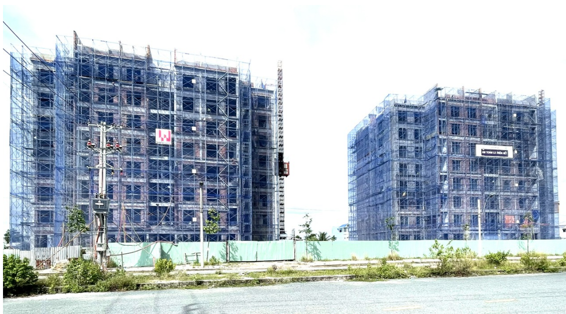
Dự án Nhà ở xã hội dành cho cán bộ, nhân viên vận hành Nhà máy Nhiệt điện Sông Hậu 1 đang thi công
