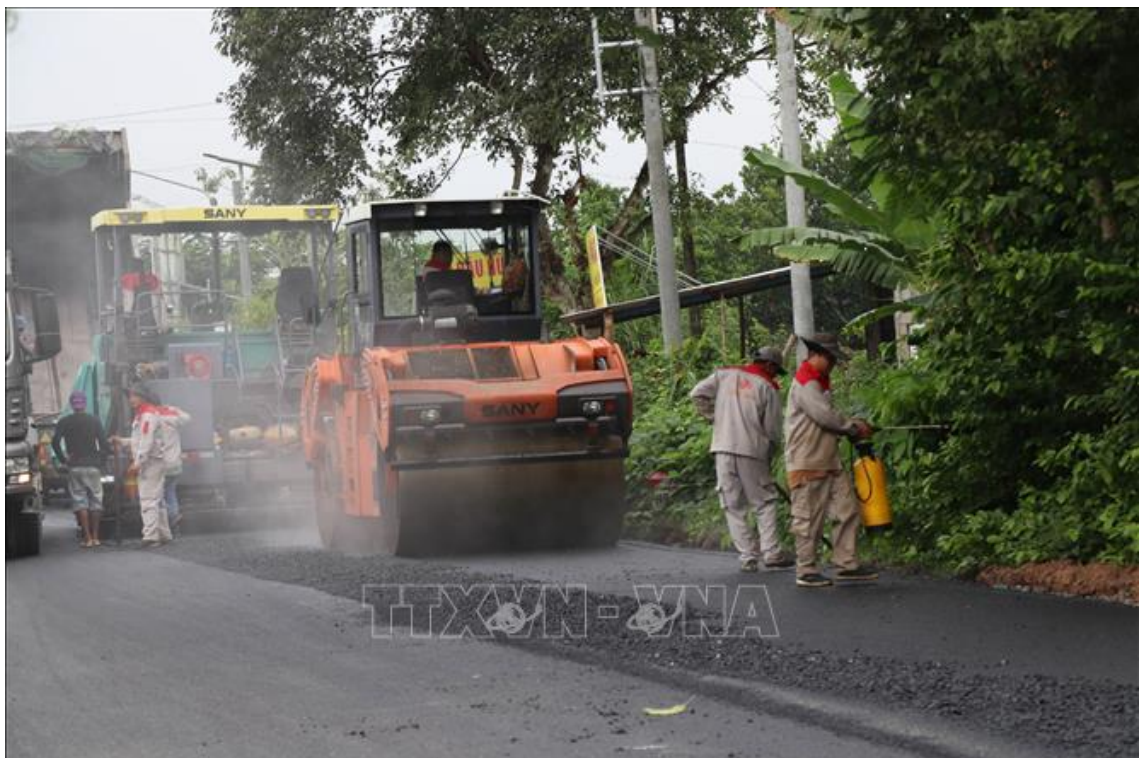
Gấp rút hoàn thiện công trình nâng cấp quốc lộ 60 tại xã Tập Ngãi, tỉnh Vĩnh Long. Ảnh: Thanh Hòa/TTXVN
