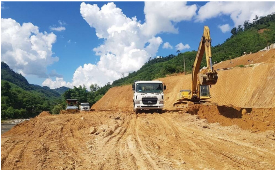
Thi công dự án QL27 đoạn tránh Liên Khương (Ảnh Báo GT)
