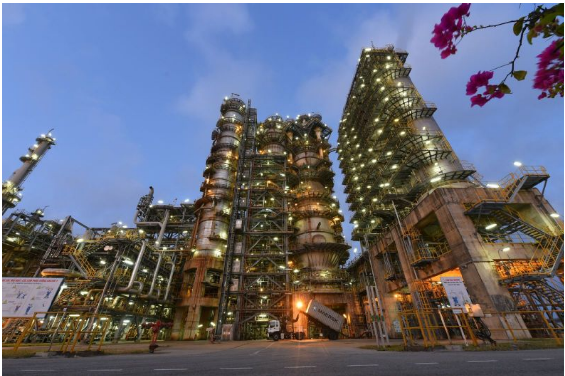
Phân xưởng RFCC - Nhà máy lọc dầu Dung Quất
