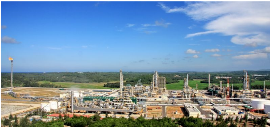
Toàn cảnh Nhà máy lọc dầu Dung Quất
