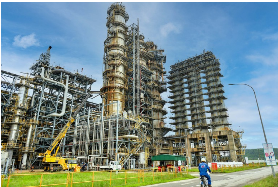
NMLD Dung Quất đang vận hành an toàn, ổn định ở công suất tối ưu
