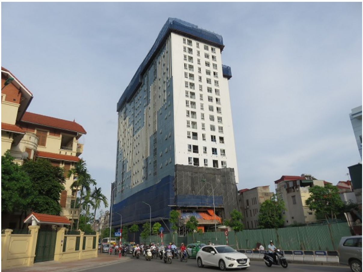
Công trình 8B Lê Trực
