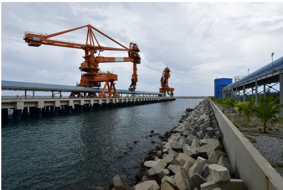
Cảng bốc dỡ than với 02 cần cẩu loại bốc được 1.600 tấn/giờ. (Ảnh: Trần Minh Ngọc)
