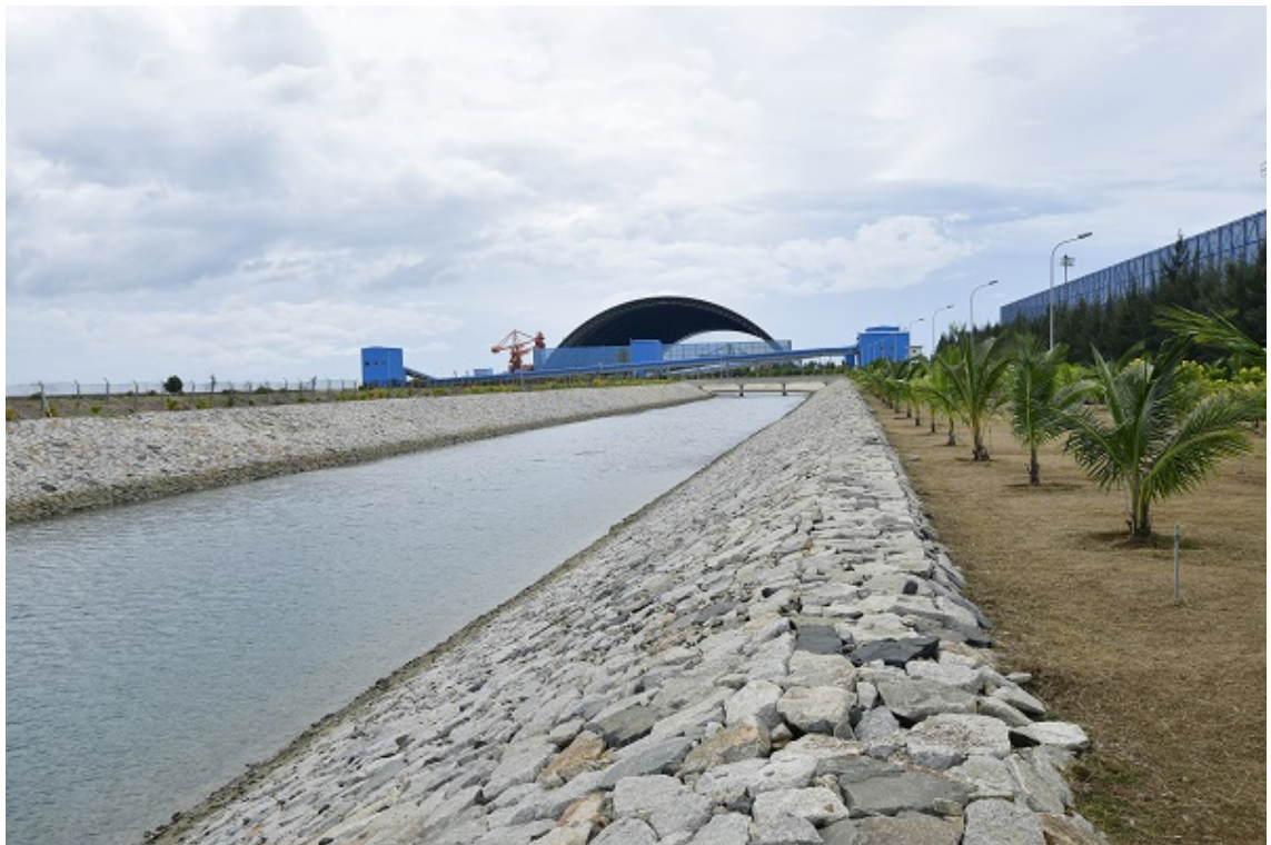
Kênh lấy nước biển dẫn vào khu lọc nước thành nước ngọt. (Ảnh: Trần Minh Ngọc)
