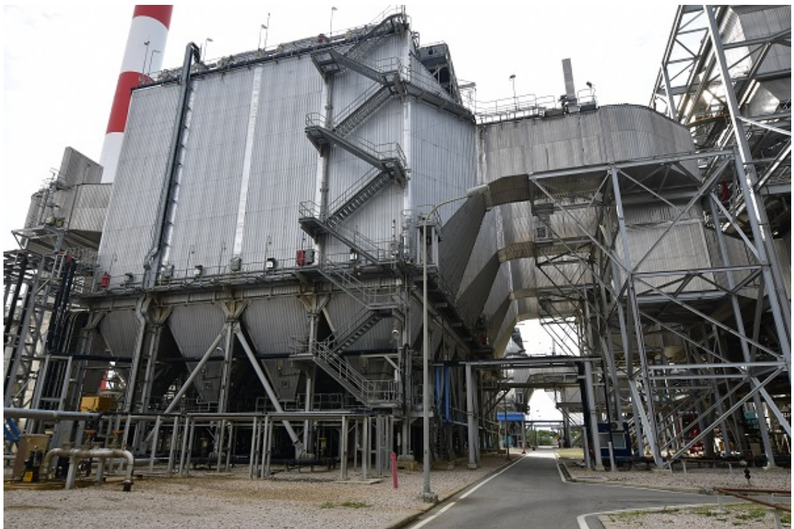
Hệ thống lọc bụi tĩnh điện khí thải trước khi đi vào ống khói thải ra môi trường. (Ảnh: Trần Minh Ngọc)
