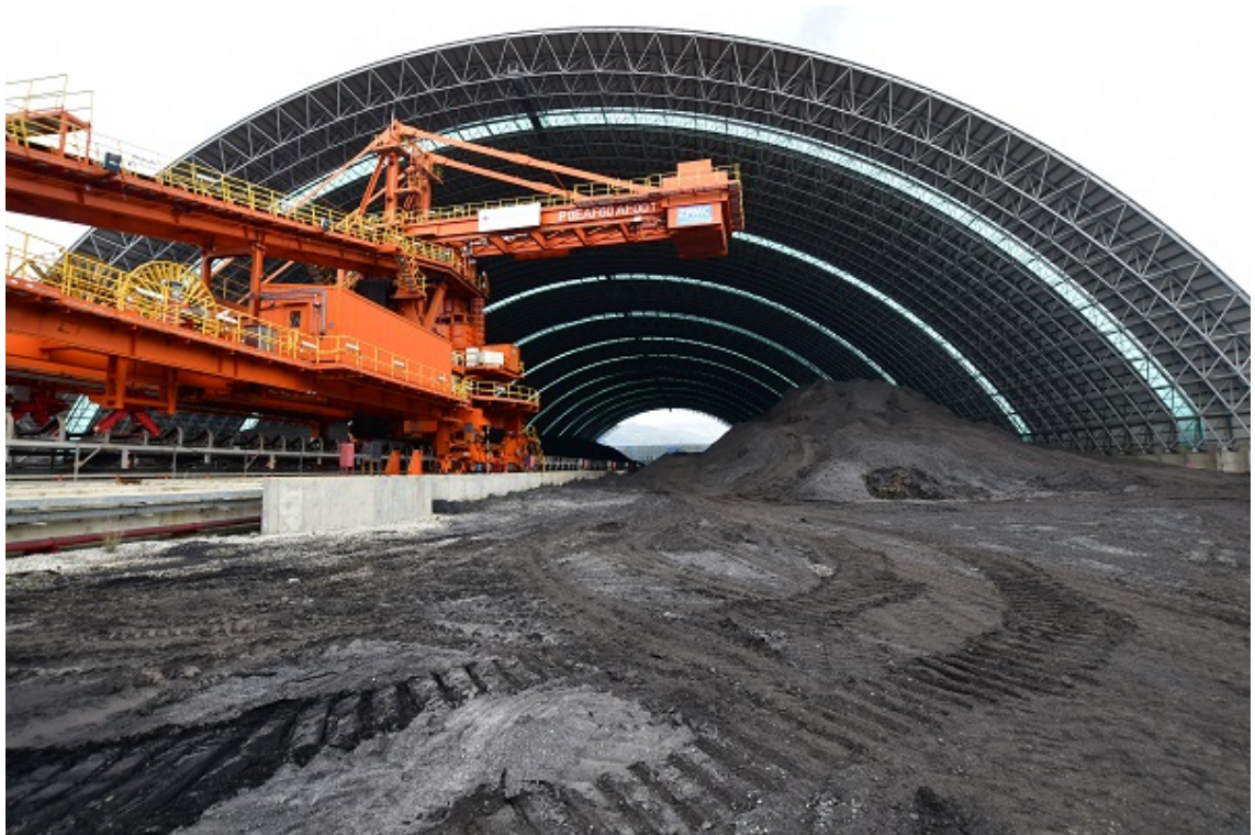
Kho than 2 : Có hàng rào lưới chắn gió bụi, có mái che, ngoài hàng rào có hàng cây phi lao chắn gió.. (Ảnh: Trần Minh Ngọc)
