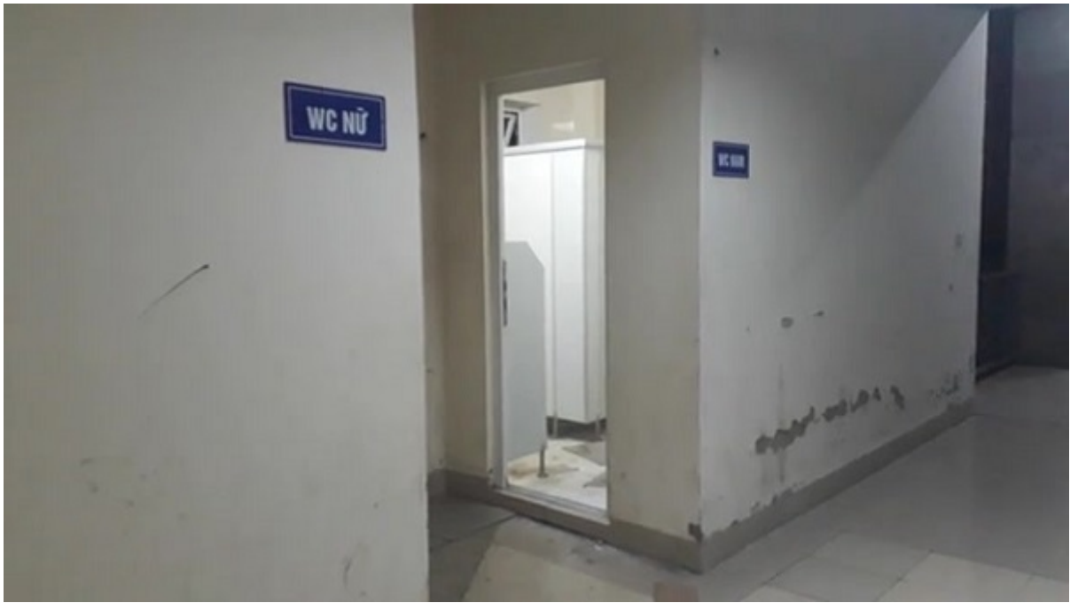
Khu nhà vệ sinh bên trong bệnh viện
