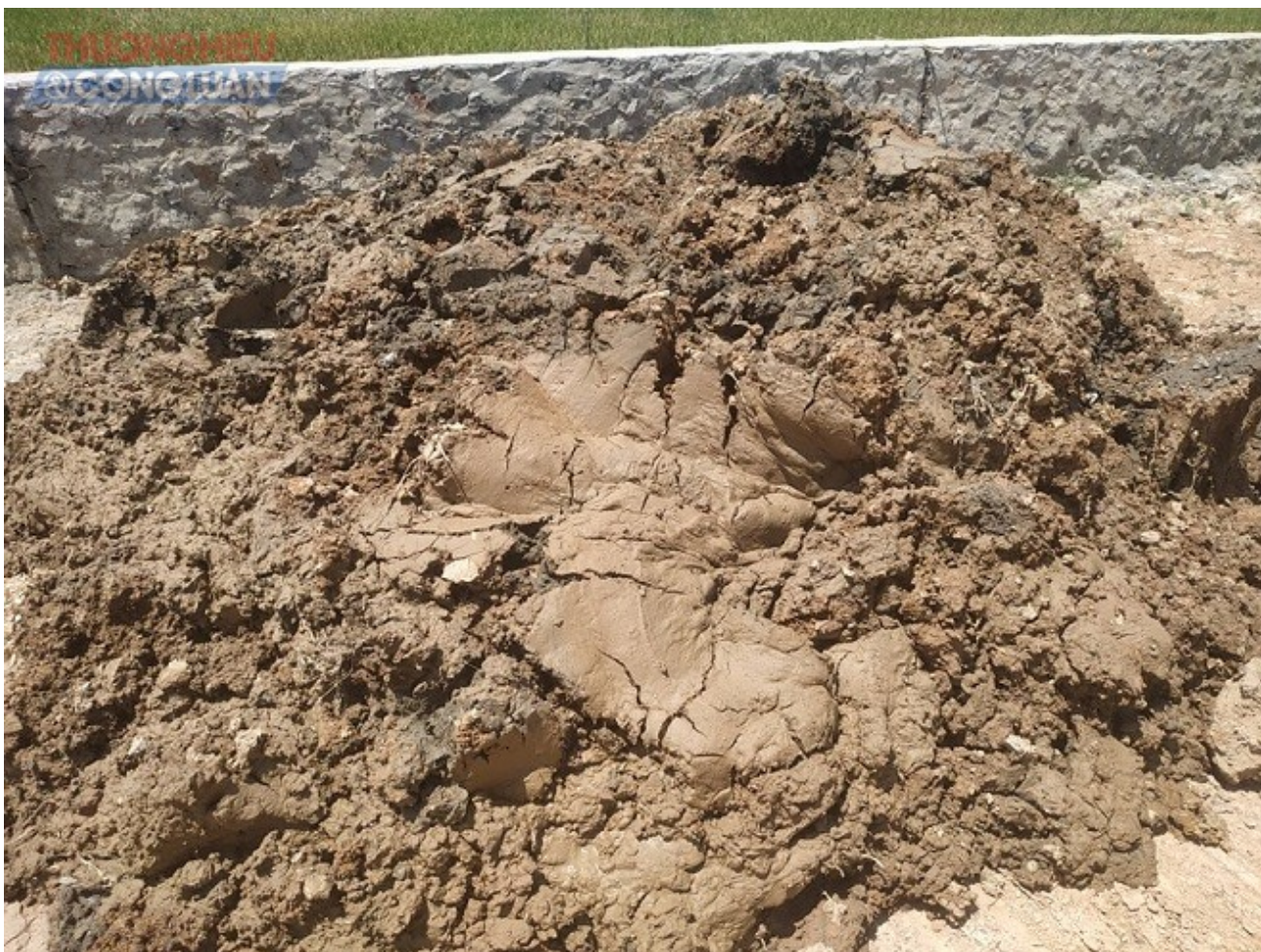
Đất bùn dùng để làm nền đường được PV ghi nhận tại công trình
