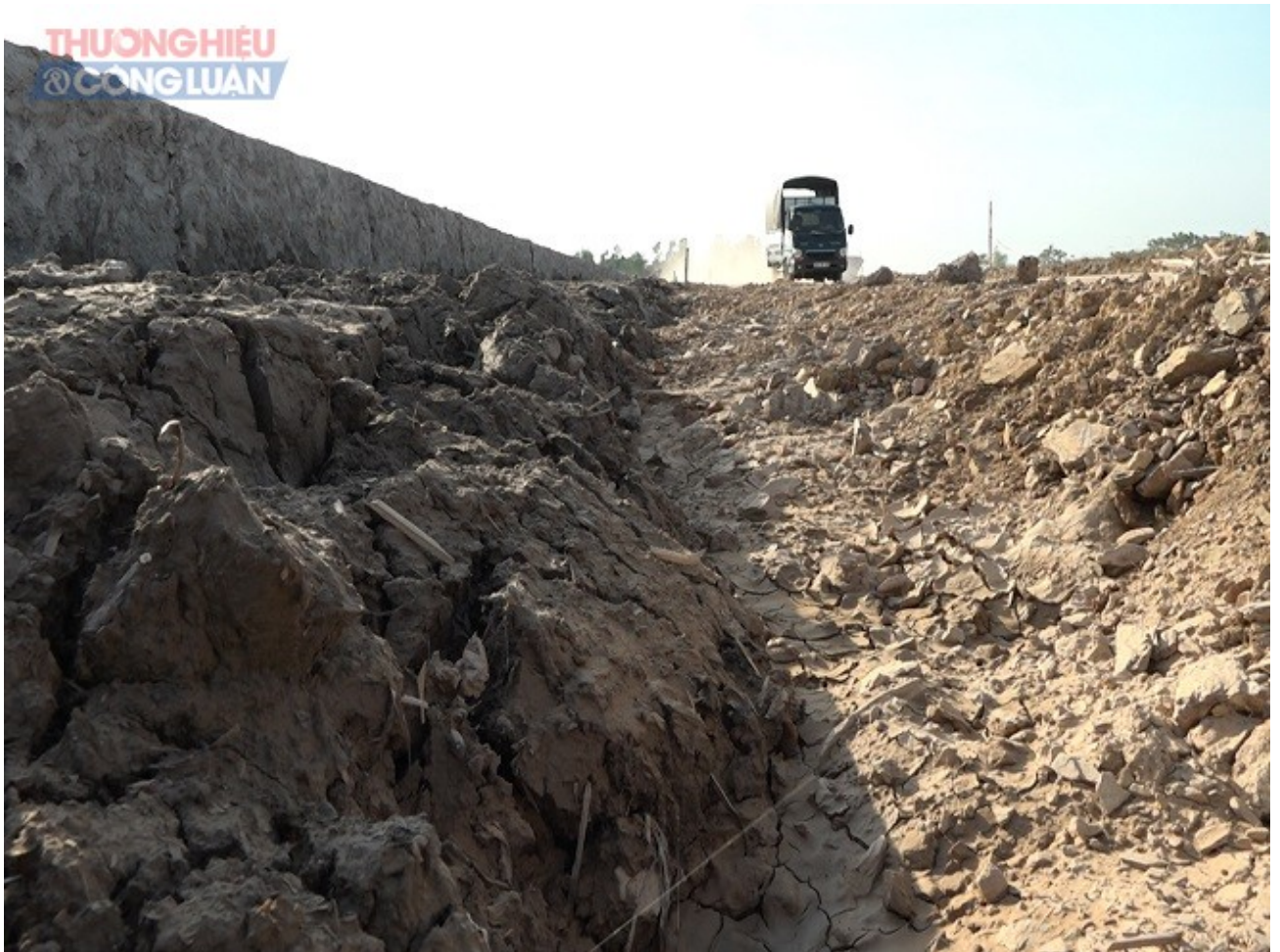
Cận cảnh lớp đất bùn được đơn vị thi công đổ xuống
