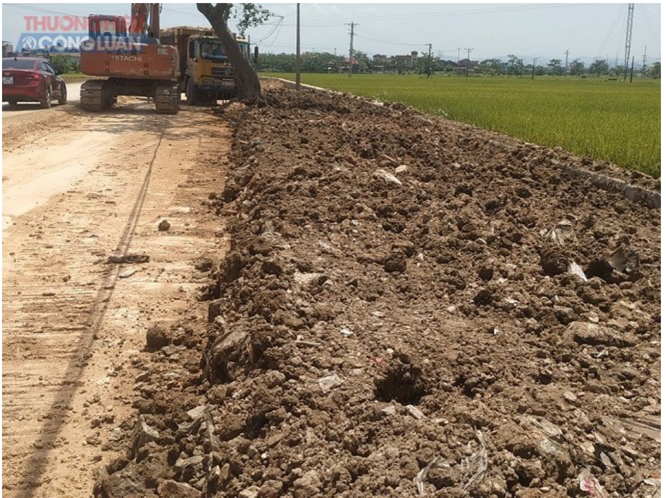
Nhiều điểm nền đường đang đổ nhiều bùn, bùn chứa nhiều rác thải
