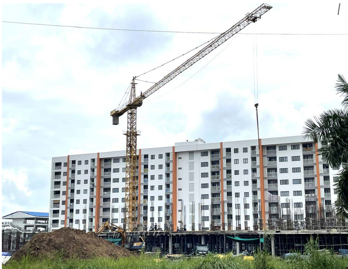
Thi công dự án Nhà ở xã hội Hồng Loan 5C
