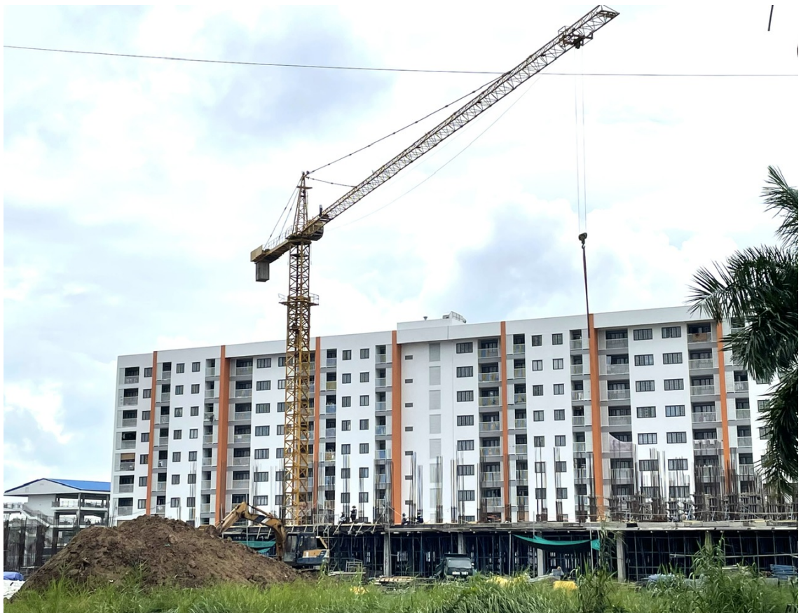
Chung cư nhà ở xã hội-Hồng Loan 5C đang thi công (Ảnh: Huỳnh Biển)
