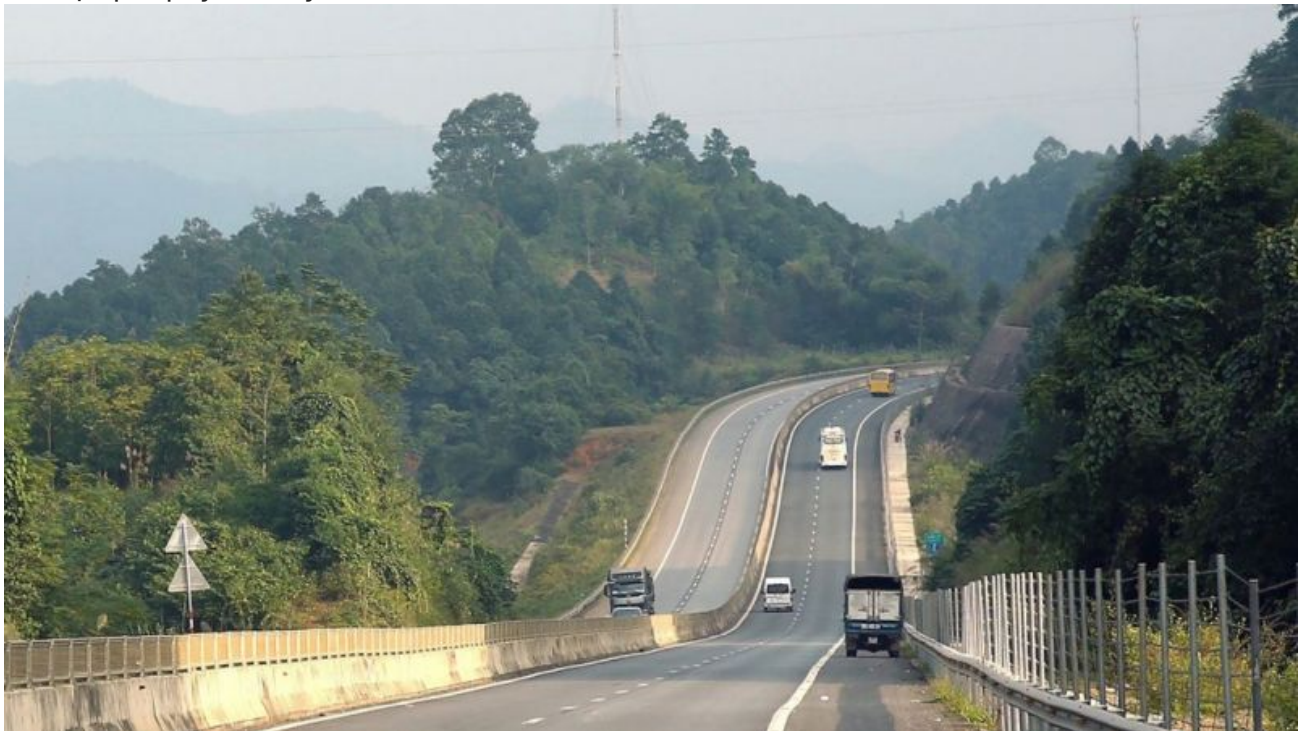
Dự án thành phần 2 - xây dựng đoạn cao tốc Hữu Nghị - Chi Lăng
