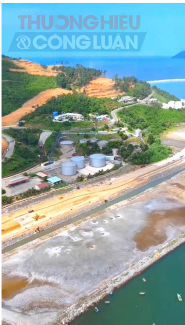
Dự án cảng Liên Chiểu đang được triển khai tại phường Hải Vân, TP Đà Nẵng.
