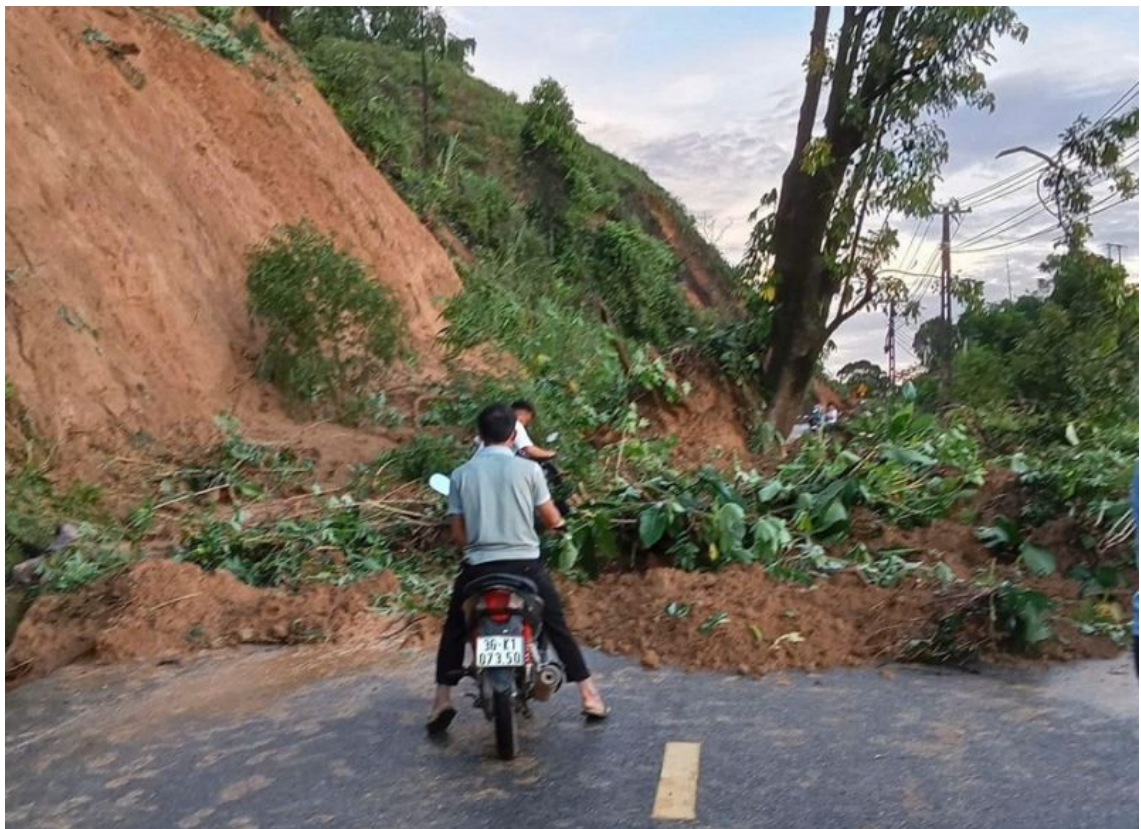
Sạt lở đất tại huyện miền núi Mường Lát, tỉnh Thanh Hóa
