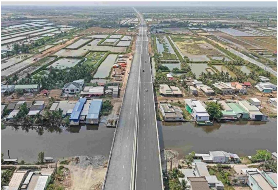
Cao tốc Hậu Giang - Cà Mau tăng tốc hoàn thiện, dự kiến khai thác dịp 30/4 (Ảnh: Nhật Hồ)
