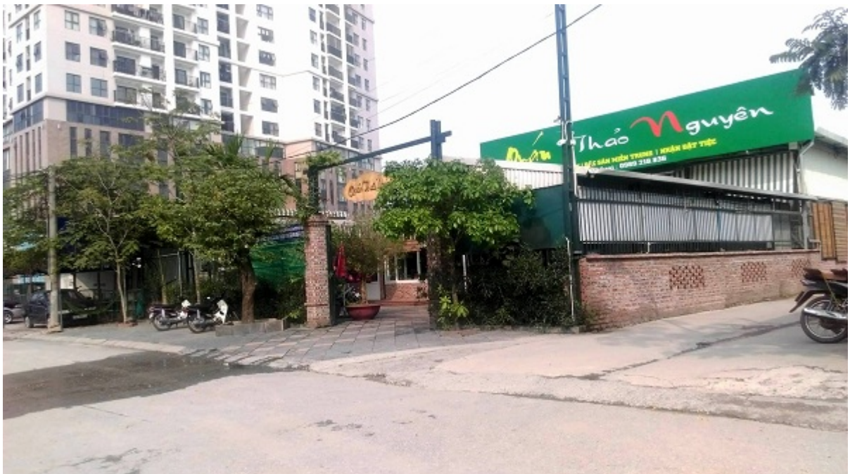
Hàng loạt công trình xây dựng không phép tại lô đất HH
