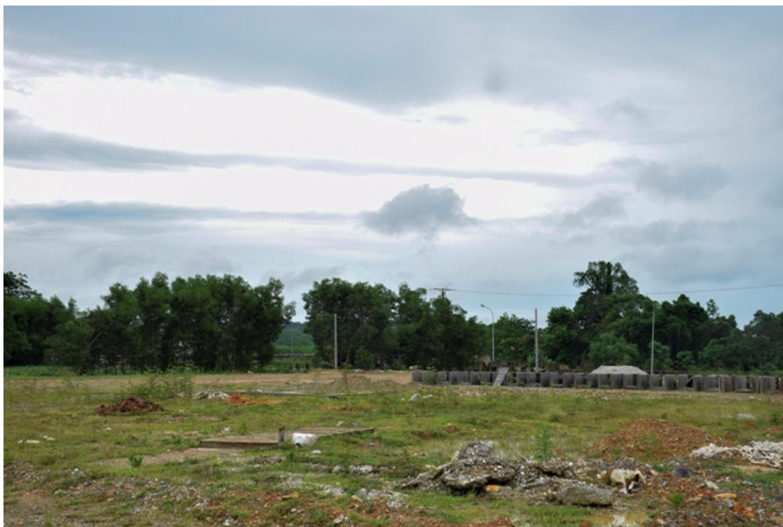
Khu tái định cư sau đập phụ 1 đang thi công dở dang. (Ảnh: P.T)
