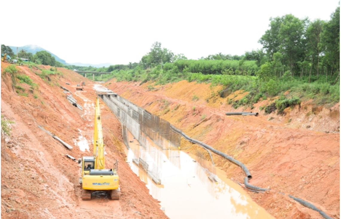
Đơn vị thi công đang thi công Kênh tiêu Châu Bình. (Ảnh: P.T)
