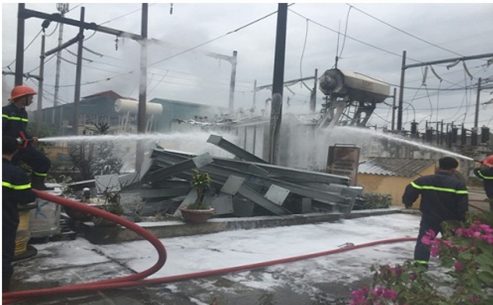
Lực lượng PCCC Bắc Ninh kịp thời khống chế vụ cháy.
