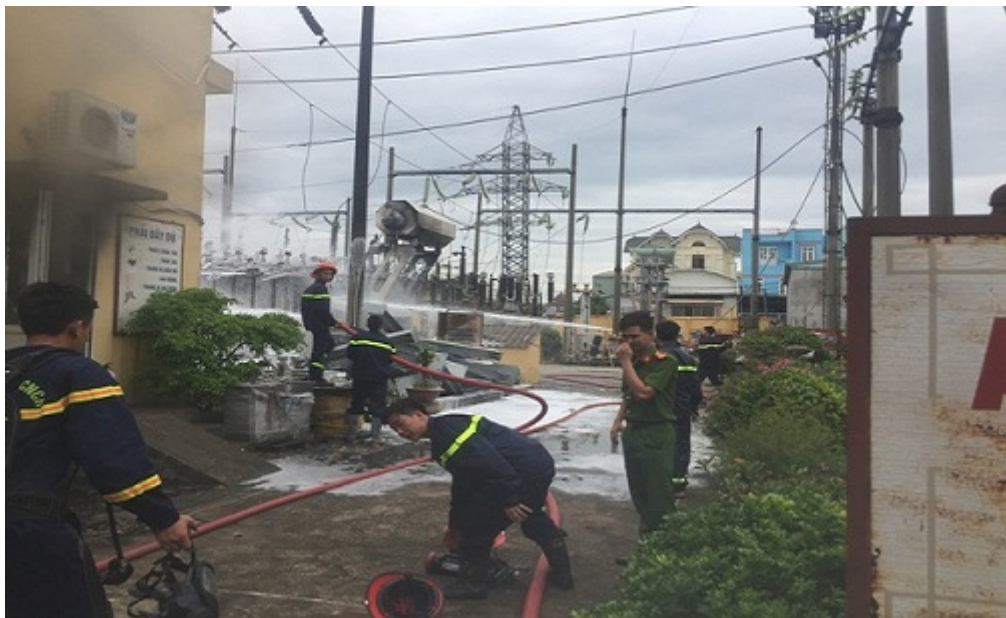
Cảnh sát Phòng cháy và Chữa cháy nỗ lực dập lửa trạm biến áp
