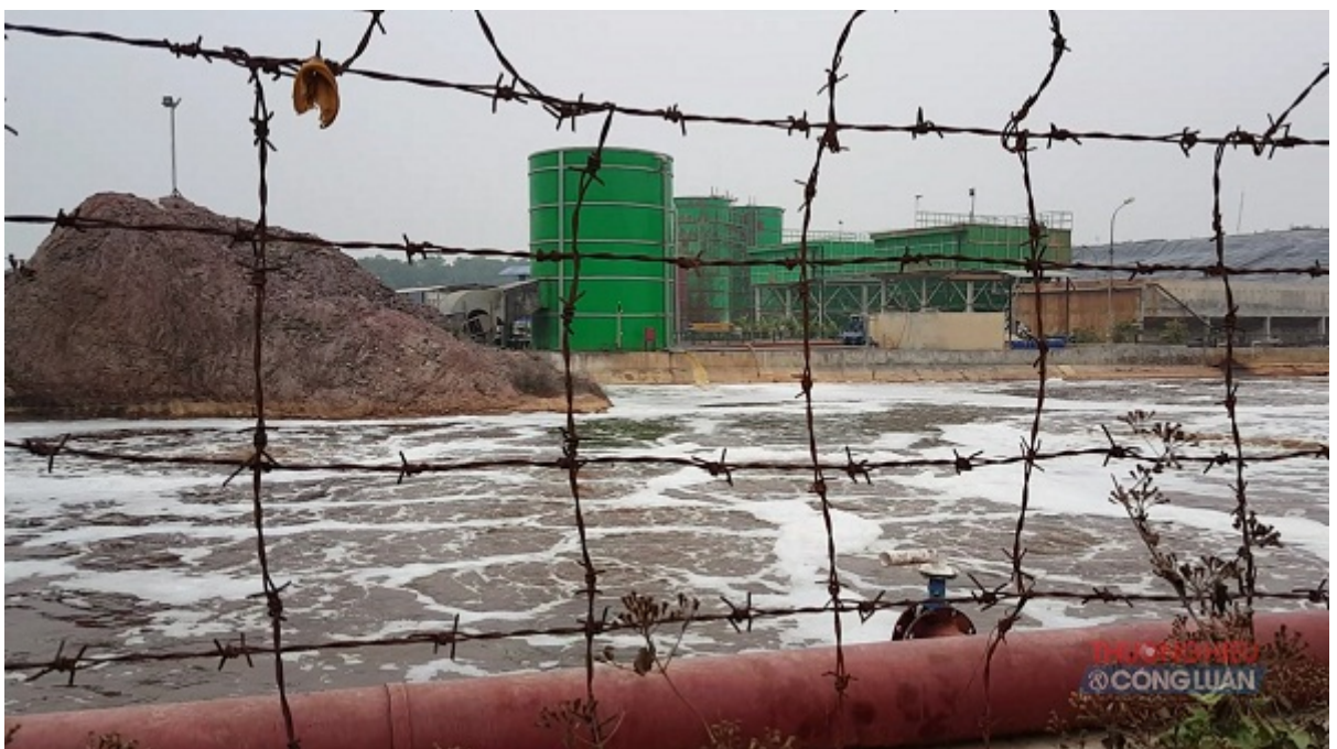
Một nhà máy xử lý nước thải trong khu liên hiệp xử lý rác thải Nam Sơn
