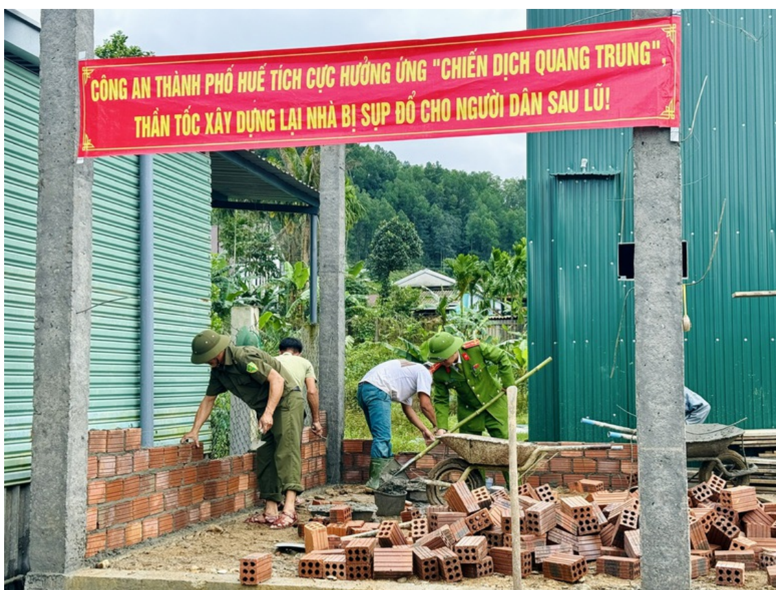
Công an thành phố Huế tham gia xây dựng nhà cho nhân dân sau lũ - Ảnh: SGGP
