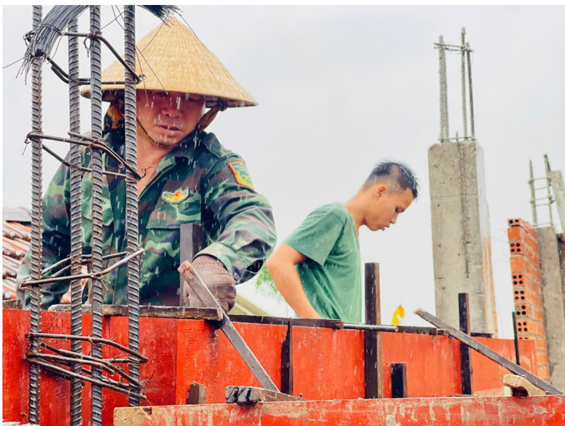
Cán bộ, chiến sĩ Tăng thiết giáp 574 (Quân khu 5) 'vượt nắng, thắng mưa' giúp dân dựng lại mái ấm ở rốn lũ Hòa Thịnh - Ảnh: VGP/NA
