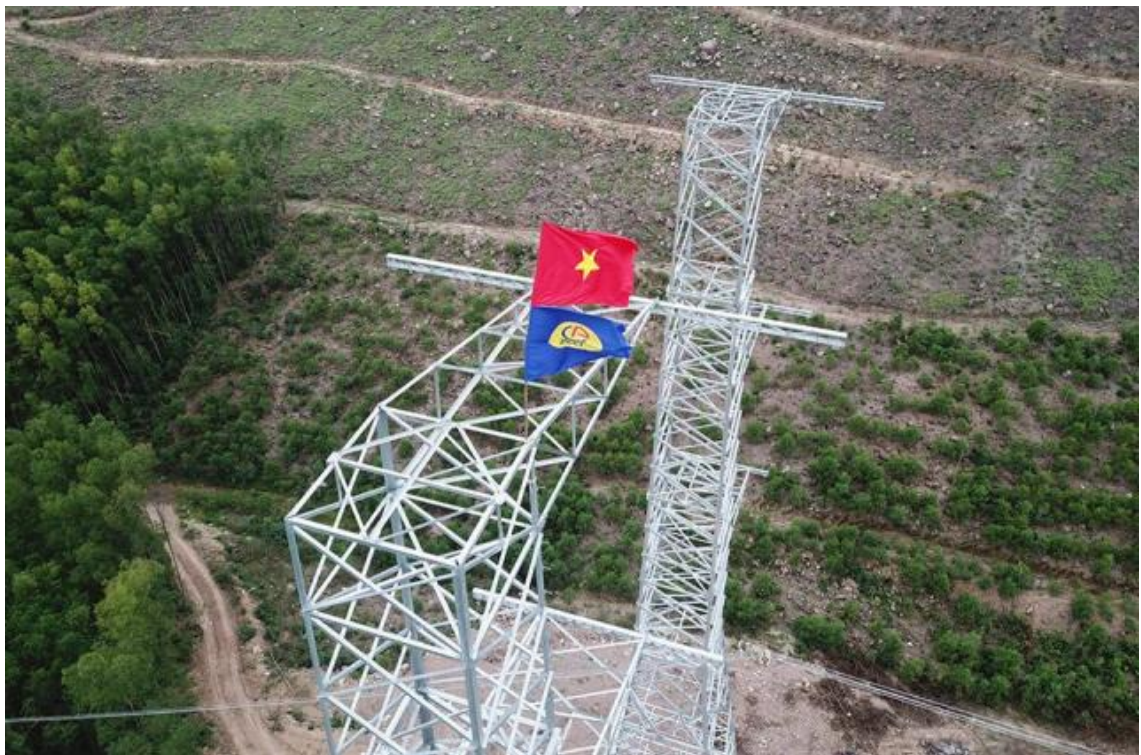
Đường dây 500kV mạch 3 đã thông tuyến.
