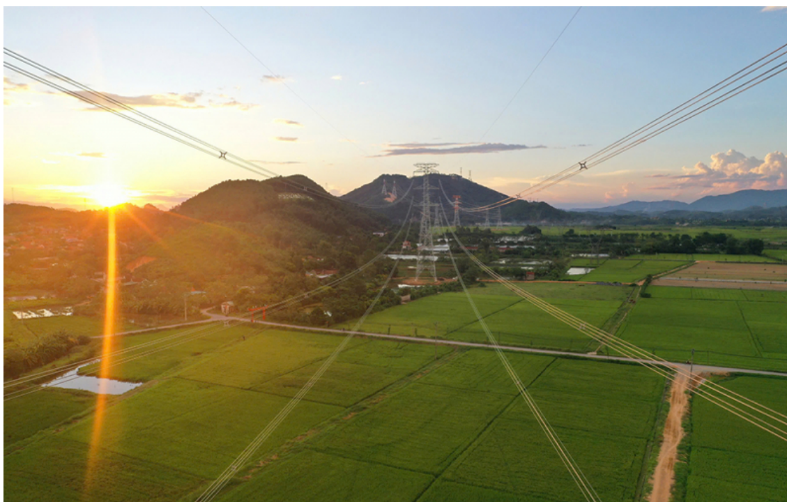
Dự án đường dây 500kV Quảng Trạch - Quỳnh Lưu hoàn thành đóng điện
