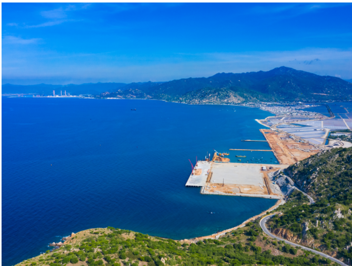
Dự án Cảng biển tổng hợp Cà Ná- Giai đoạn 1 tại huyện Thuận Nam, tỉnh Ninh Thuận (Ảnh: TLCT)
