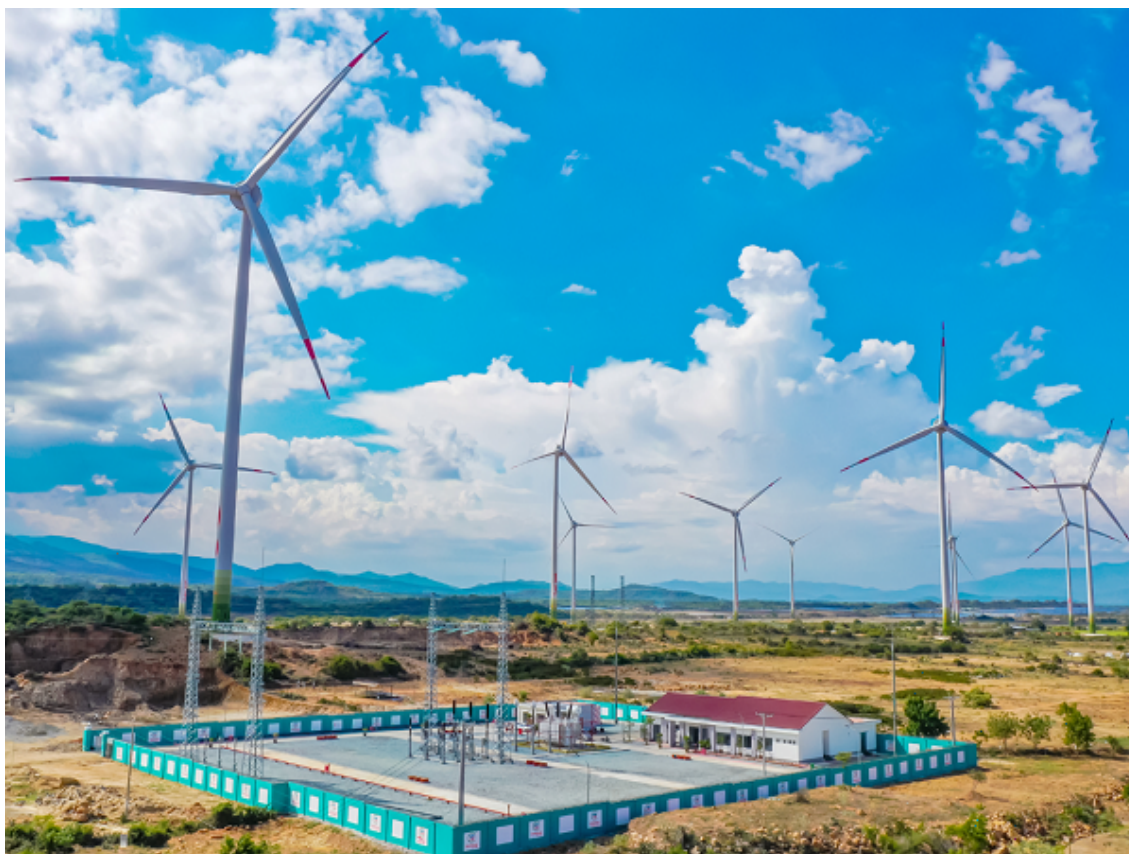
Dự án Điện gió số 5- Ninh Thuận tại huyện Ninh Phước, tỉnh Ninh Thuận (Ảnh: TLCT)
