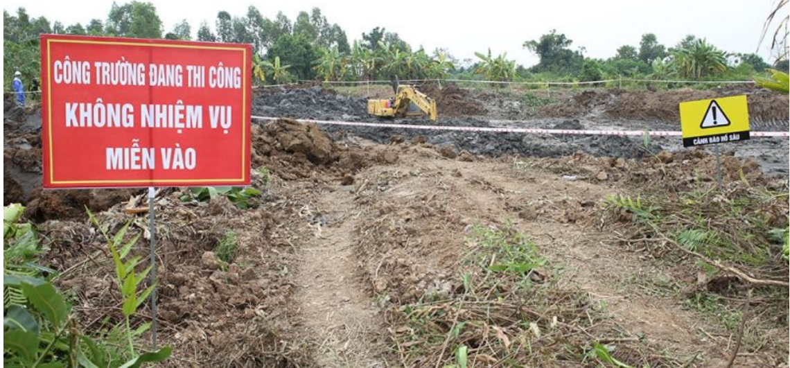
Một vị trí móng cột Dự án Đường dây 500kV NMNĐ Nam Định I – Thanh Hóa đang triển khai đào móng
