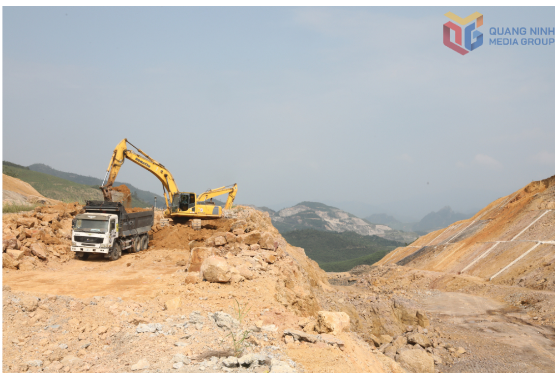
Hiện các nhà thầu đang tập trung thực hiện đào, đắp nền đường. (Ảnh: QMG)
