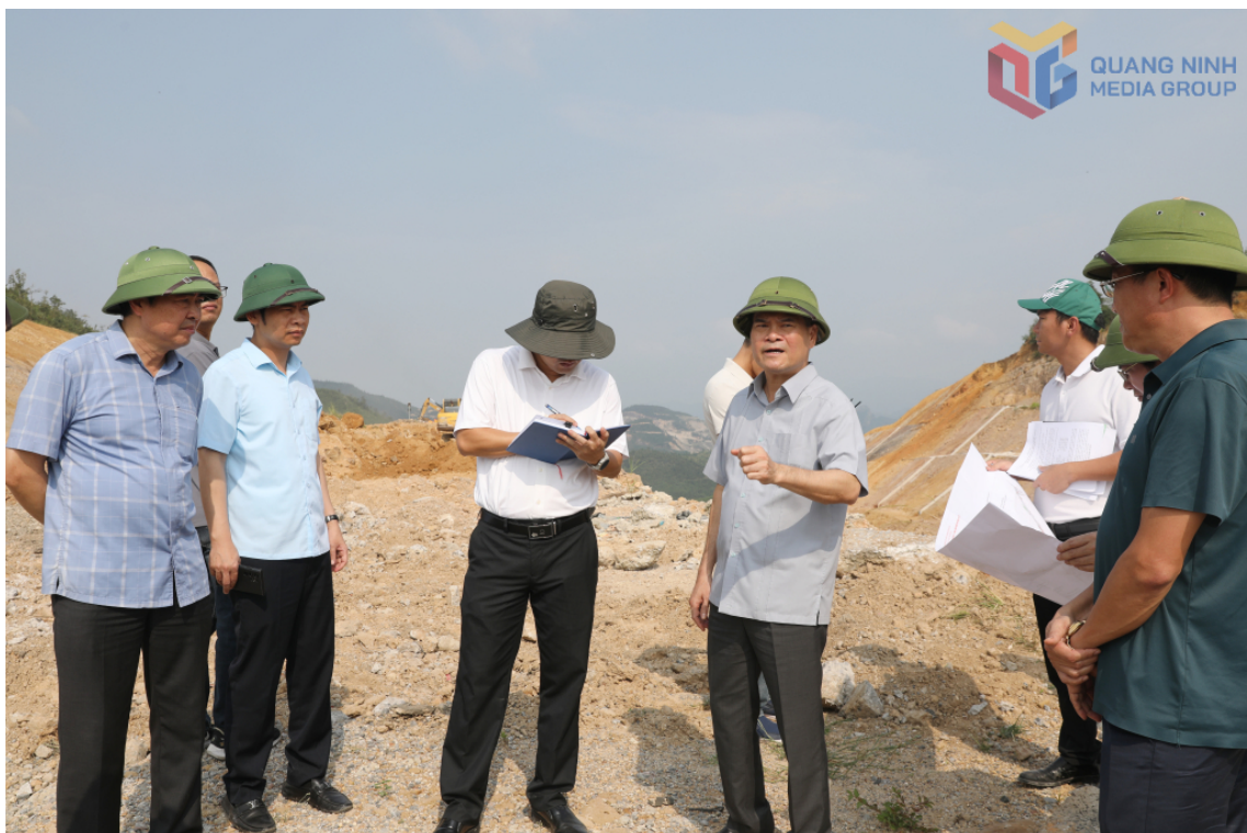
Chủ tịch UBND tỉnh Quảng Ninh kiểm tra công tác tổ chức thi công và chỉ đạo giải quyết một số khó khăn, vướng mắc nhằm đẩy nhanh tiến độ dự án cải tạo, nâng cấp QL279. (Ảnh: QMG)
