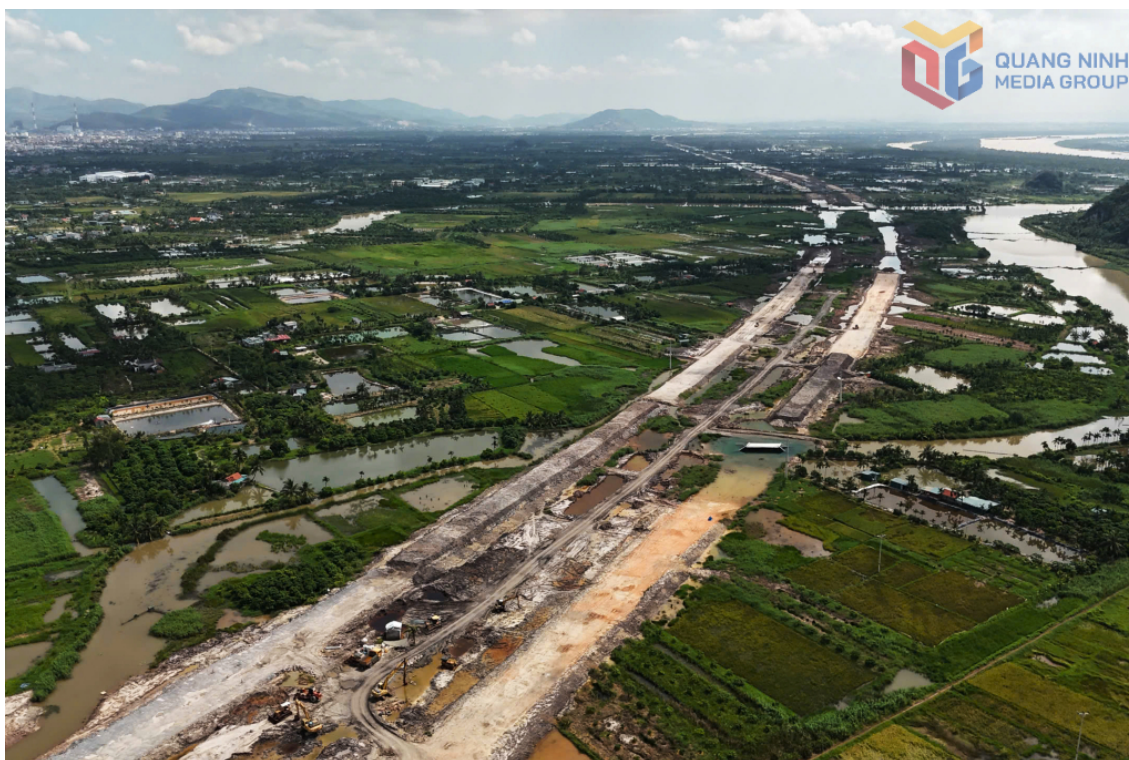
Toàn cảnh công trường dự án nhìn từ trên cao. (Ảnh: QMG)
