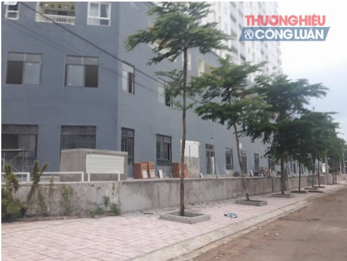
Tầng trệt Linh Tây Tower vẫn ngổn ngang
