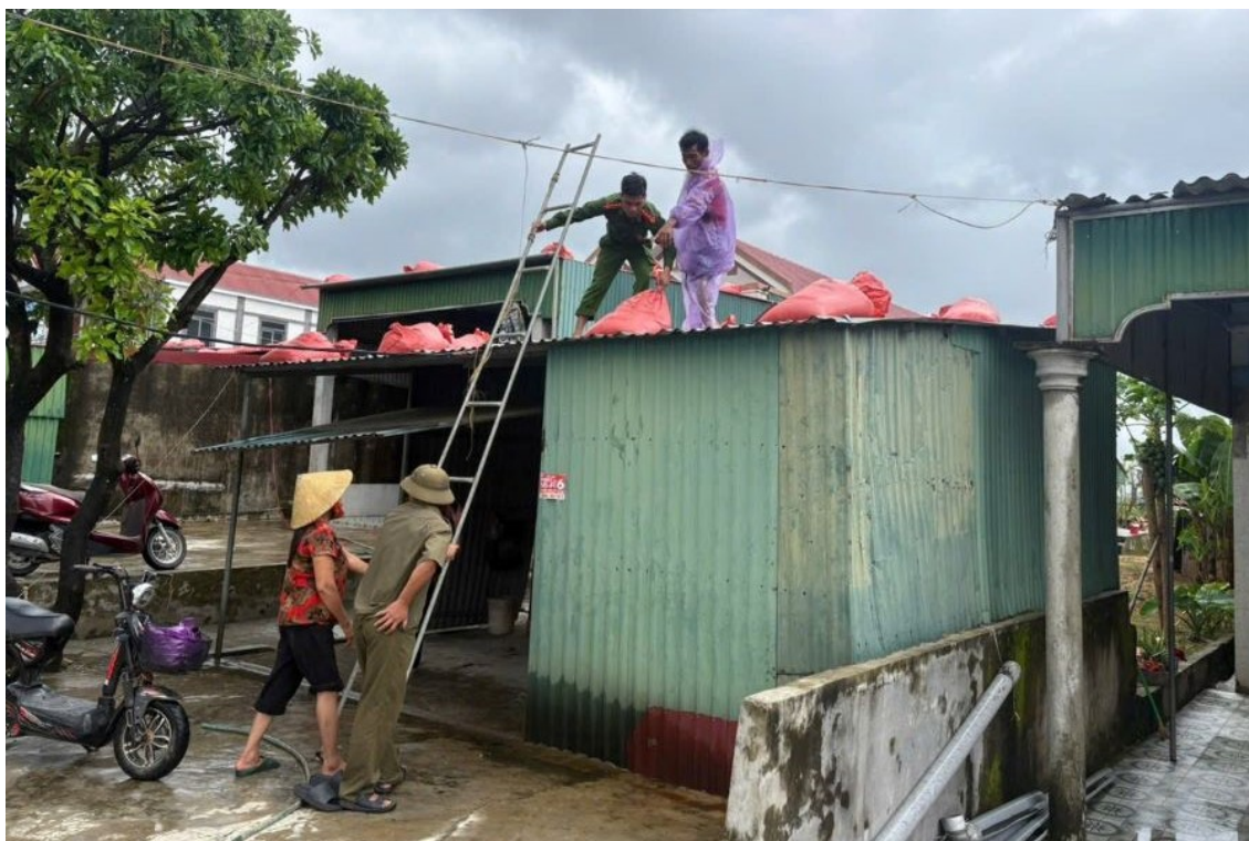
Lực lượng Công an giúp đỡ nhân dân gia cố, chằng chống nhà cửa trước khi bão đổ bộ.
