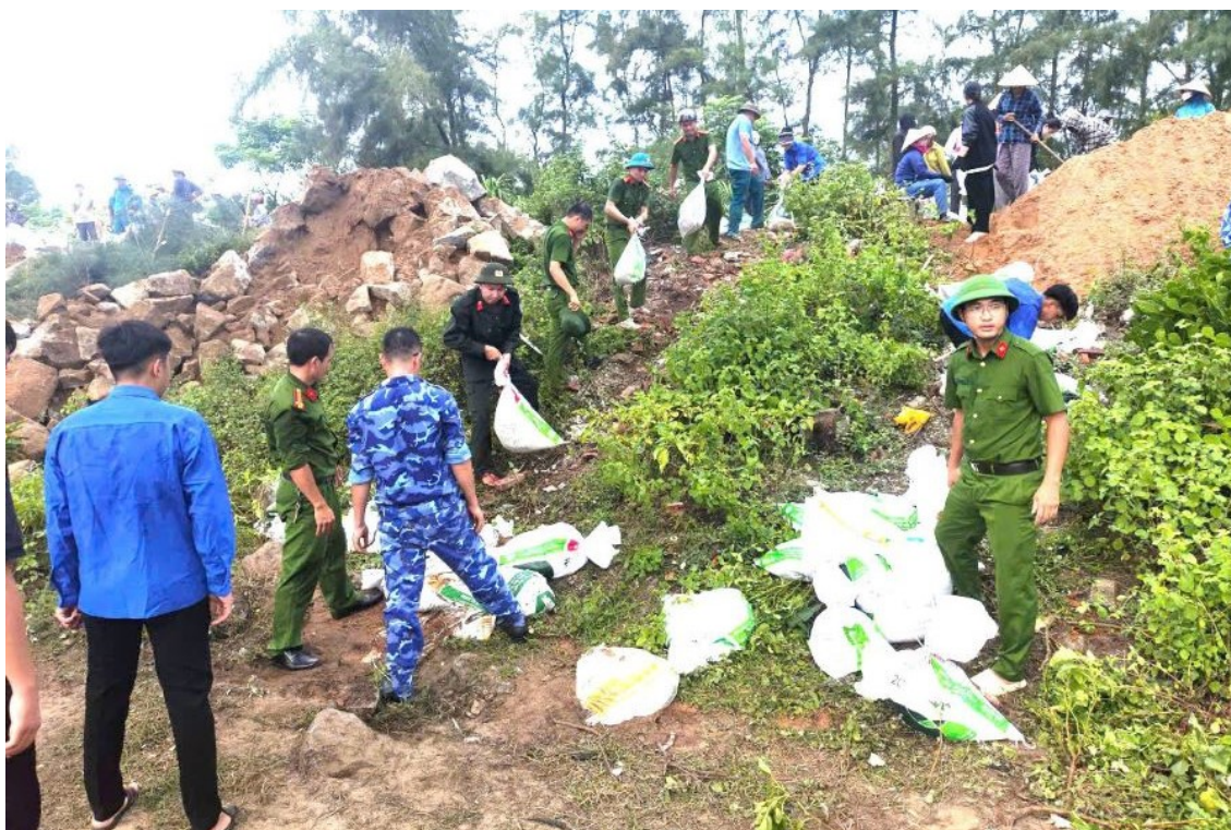
Lực lượng Công an tham gia gia cố tuyến đê biển trọng yếu.
