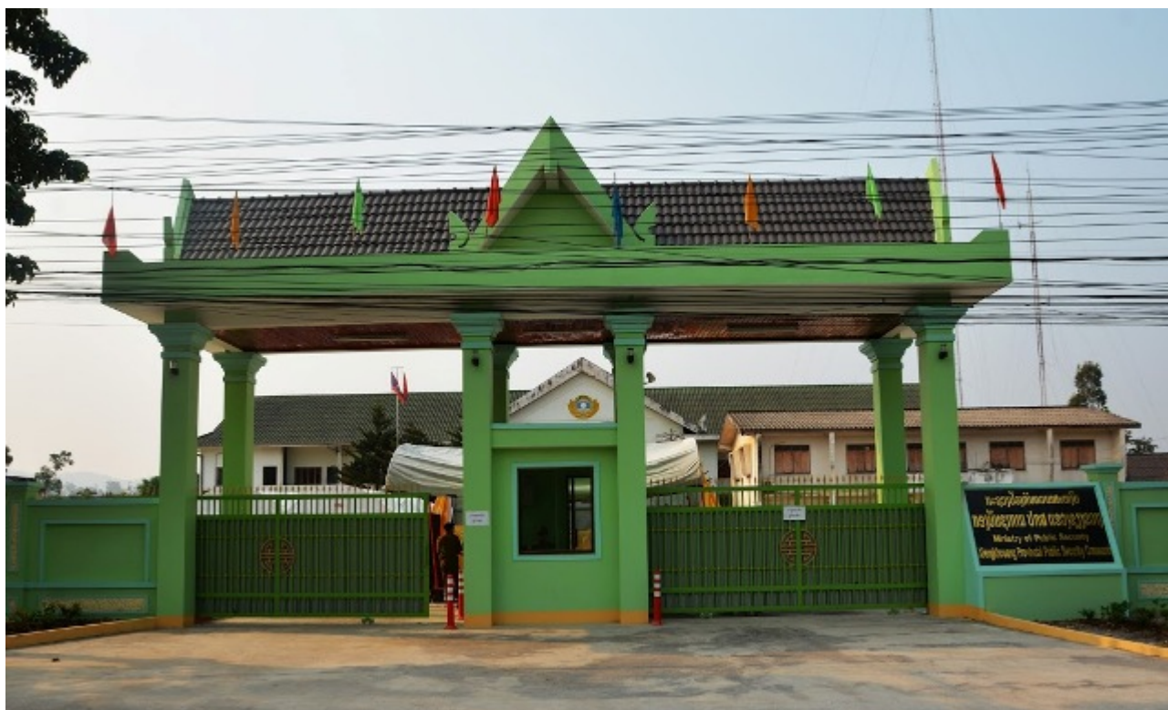
Cổng chính Công an Xiêng Khoảng được Công an Nghệ An hỗ trợ xây dựng (Ảnh: CANA)
