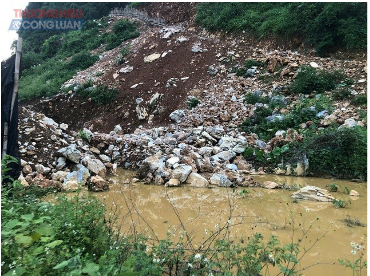
Công ty "tự ý" mở đường từ tỉnh lộ 170 vào mỏ khai thác đá
