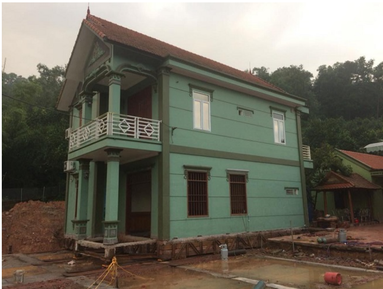
Công trình tại TP. Hải Phòng được Công ty VNSS di dời thành công
