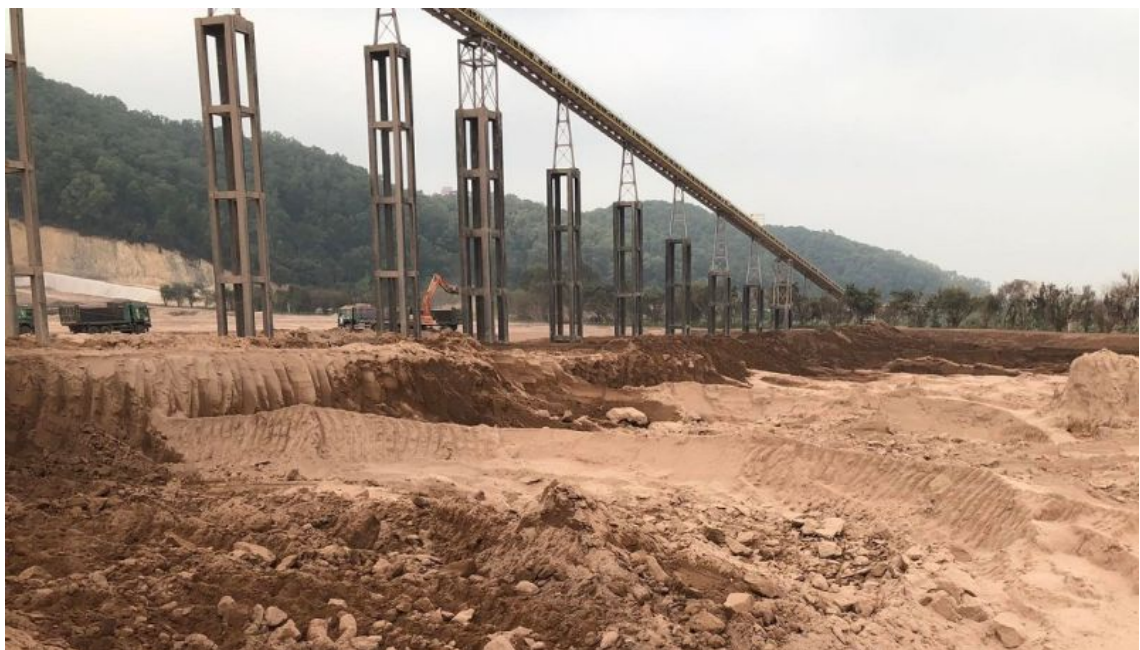
Khu vực đất rừng phòng hộ tại Nhà máy Nhiệt điện BOT Hải Dương
