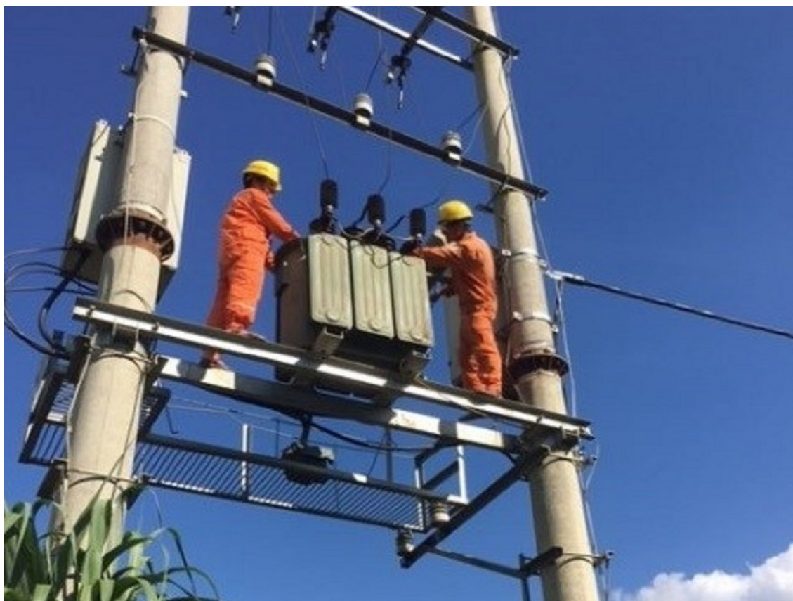
Thực hiện thay máy biến áp.
