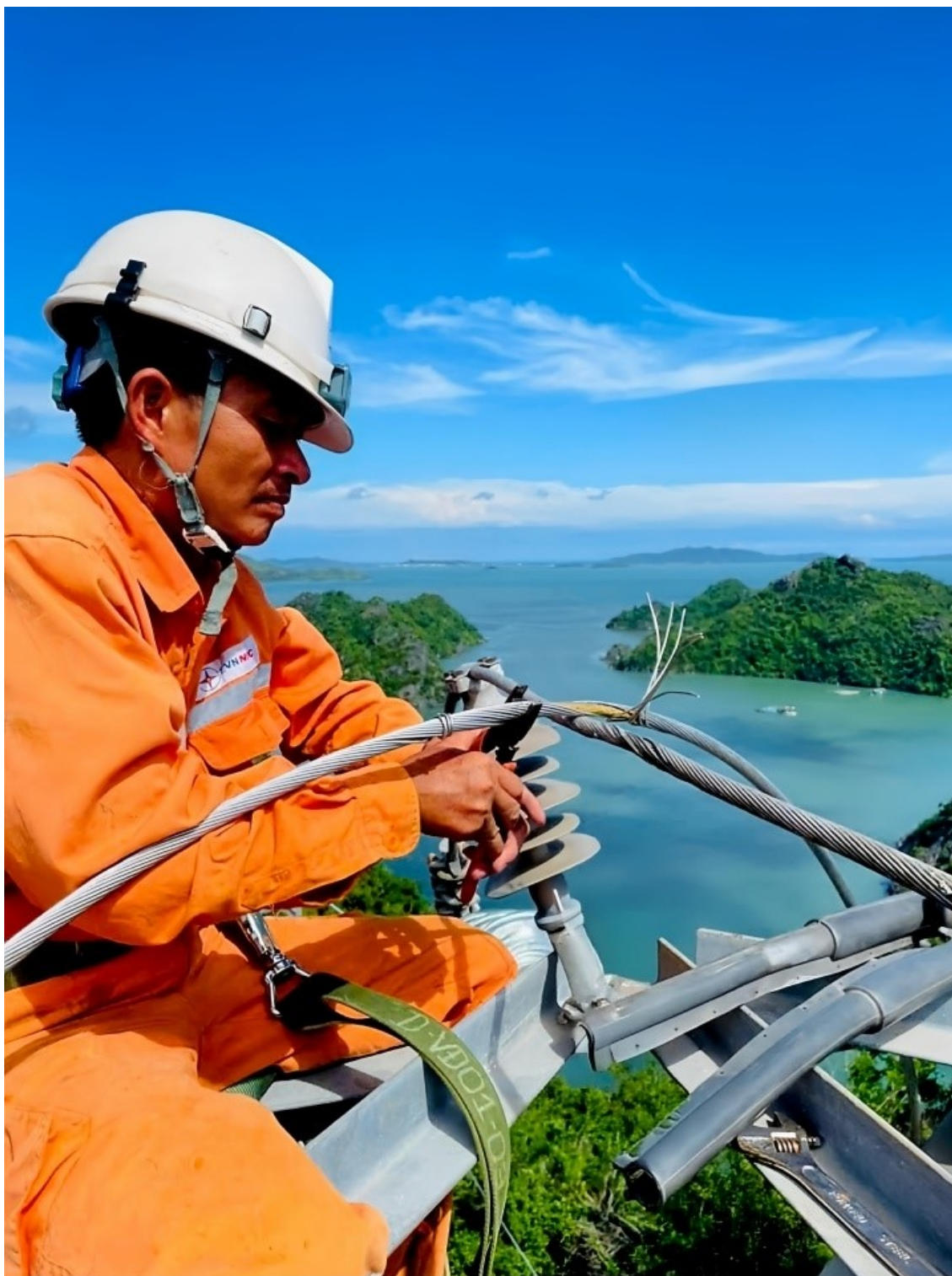
Nhân viên Đội Quản lý điện lực khu vực Vân Đồn (CTĐL Quảng Ninh) thực hiện sửa chữa, bảo dưỡng đường dây 22kV cấp điện ra đảo
