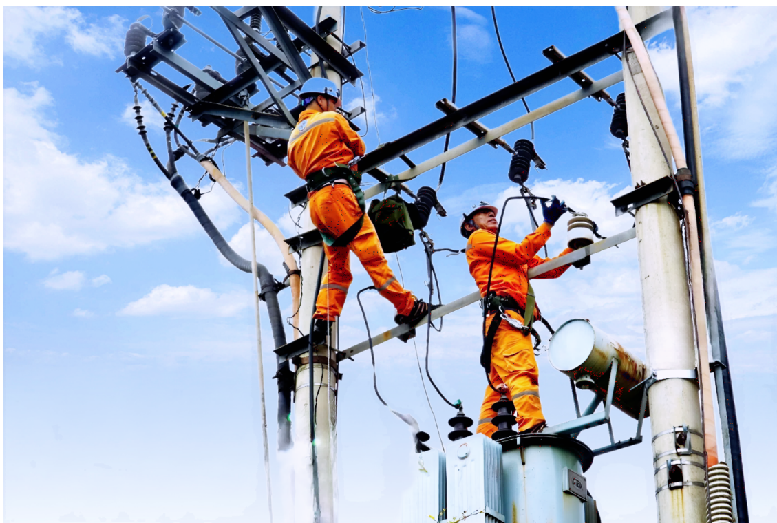
Nhân viên Đội Quản lý điện lực khu vực Hạ Long xử lý khiếm khuyết lưới điện trung thế
