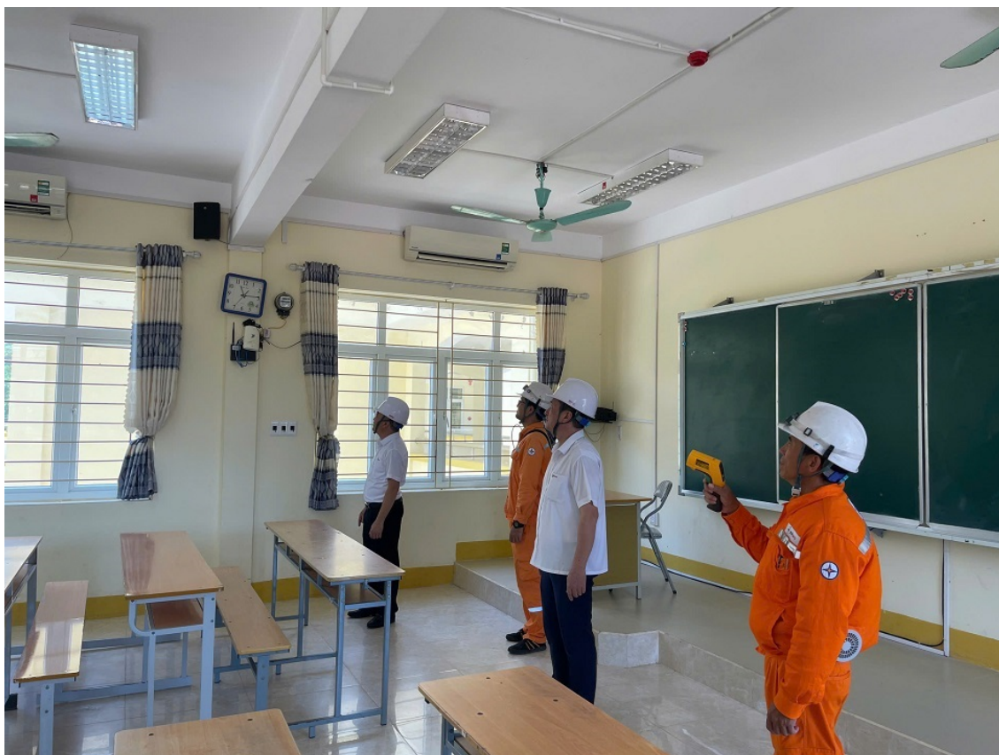
Điện lực Hải Hà kiểm tra hệ thống điện tại các điểm thi
