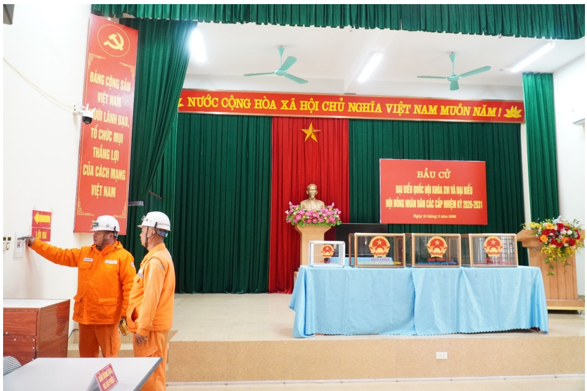
Kiểm tra hệ thống điện địa điểm bầu cử tại Nhà văn hóa khu 6 phường Hạ Long
